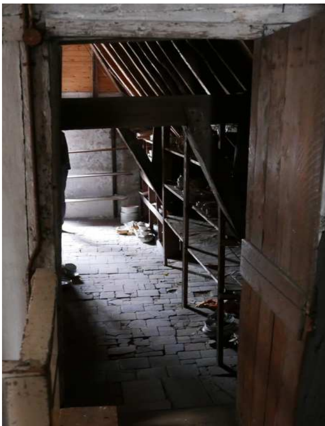
De zoldervloer in het achterhuis van Vughterstraat 19
