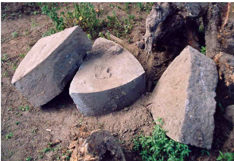
Ijsbrekerstenen gevonden op het Vughtereiland en behorend bij de voorloper van de huidige Vughterbrug
